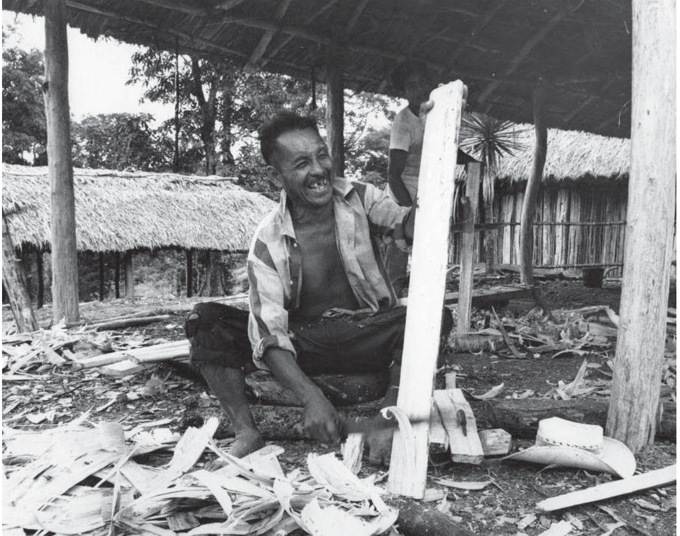
Con el machete se cortan tablas y vigas. Sin usar clavos se amarran las vigas y la construcción con bejuco.
