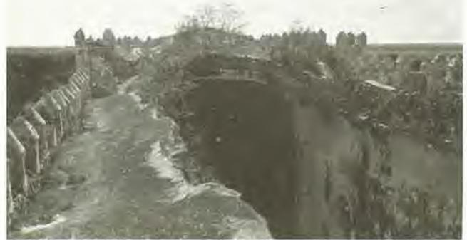
Detalle de la bóveda de la nave antes de su restauración. La fractura de la bóveda se debió al fallo de los cimientos y, por consiguiente, de la pared lateral del lado de la Epístola. Las filtraciones y las goteras hicieron el resto. Fotografía de M. Bretos, 1977.
