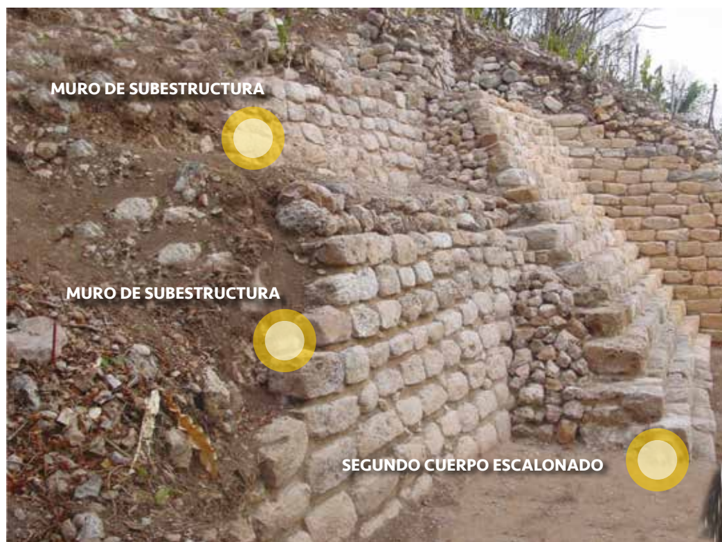
Figura 9. Muros de retención (subestructura y muros escalonados) del basamento elevado de la Acrópolis de Xocnaceh, Yucatán. (Foto por Rossana May Ciau, Proyecto Xocnaceh).
