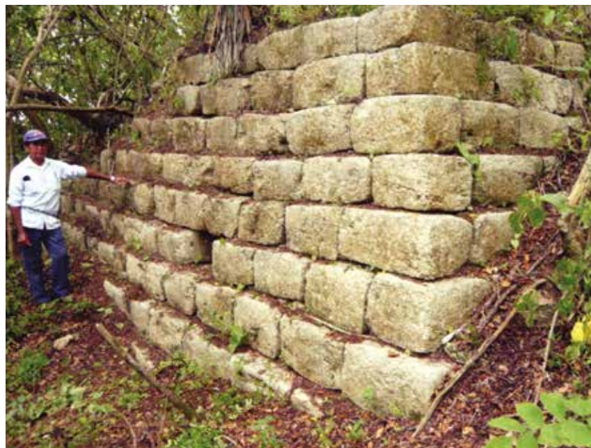
Figura 10. Muro de retención escalonado de un basamento elevado de San Francisco Xtuk, Ticul, Yucatán. (Foto por Tomás Gallareta Negrón).
