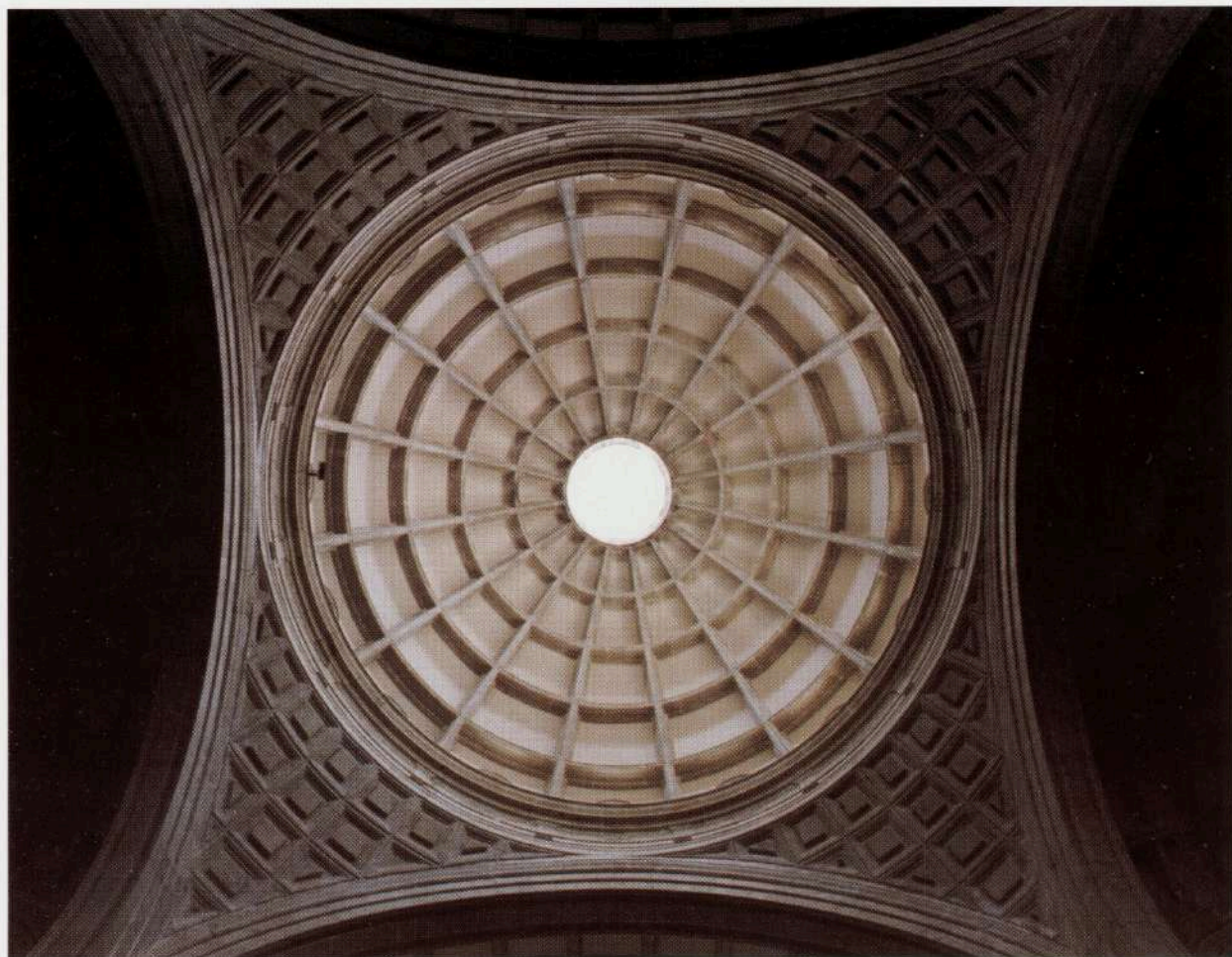
Techo del domo
